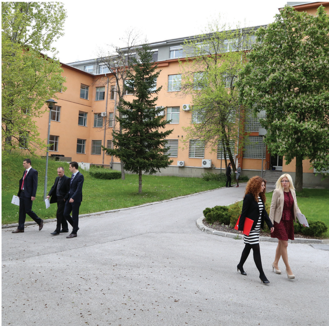
Zgrada Suda i Tužilaštva Bosne i Hercegovine
