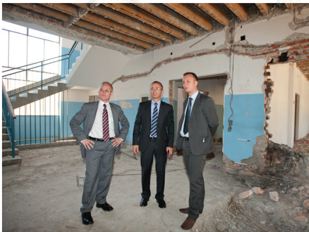
Zgrada Osnovnog suda u Modriči prije rekonstrukcije
