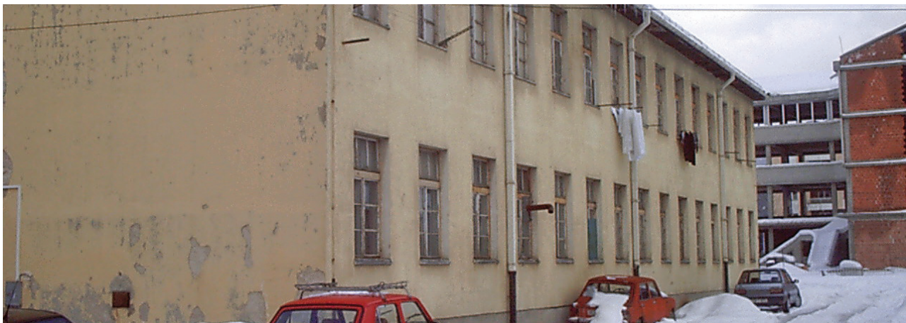
Okružni sud u Istočnom Sarajevu prije rekonstrukcije
