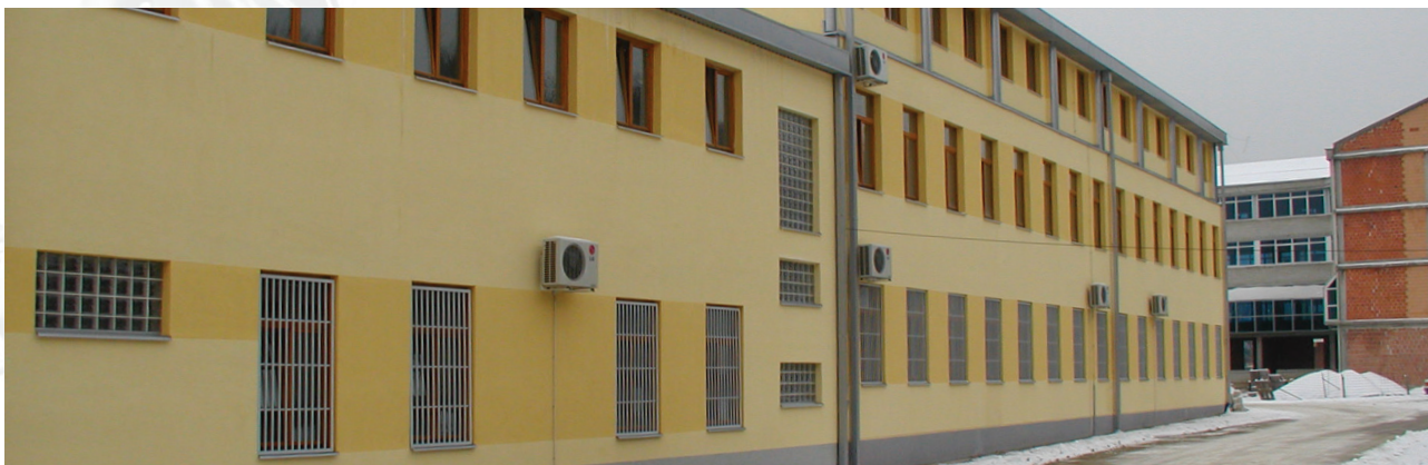
Savremena zgrada prilagođena potrebama građana, nakon rekonstrukcije
